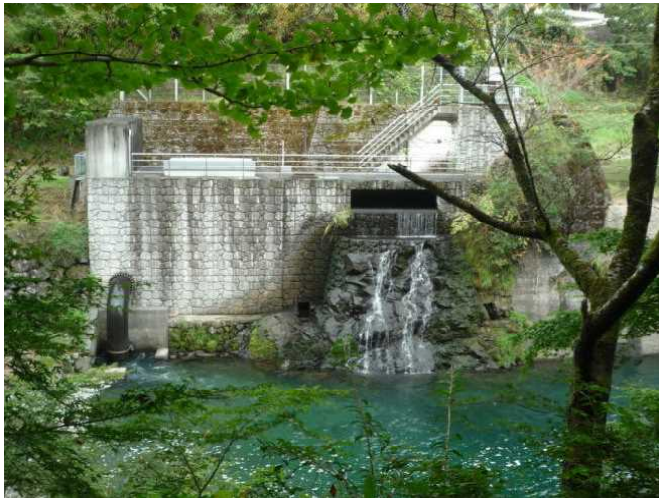
わずか6mの落差を利用する小水力発電所
